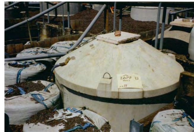
Pose d'une station BIOFRANCE 8 E.H.
