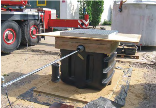
Montage de la ligne de test
